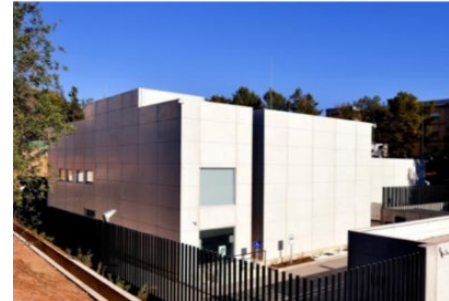
KIO Networks Data Center, Испания
