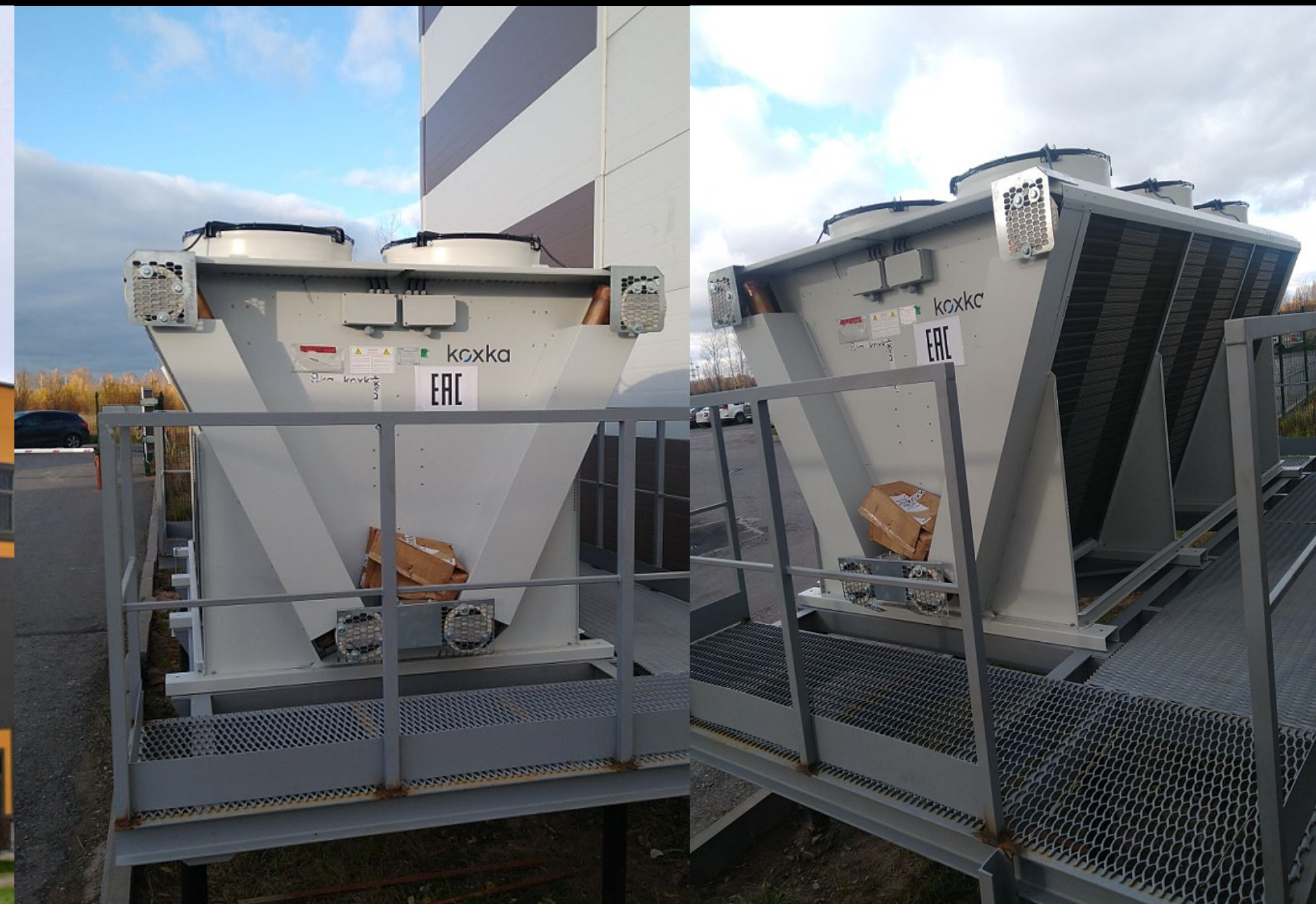
Сухой охладитель (драйкулер) Мощность 380 кВт
