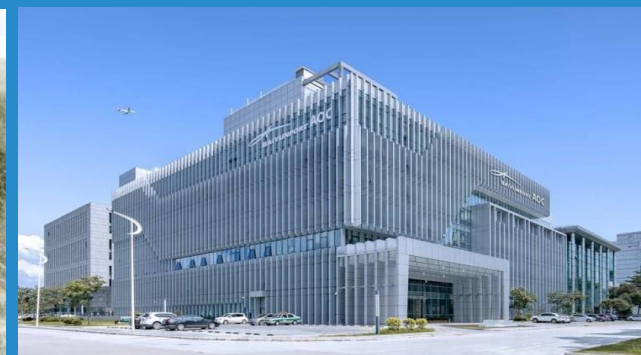
Дата Центр Vaiyun | Гуанчжоу, Китай
